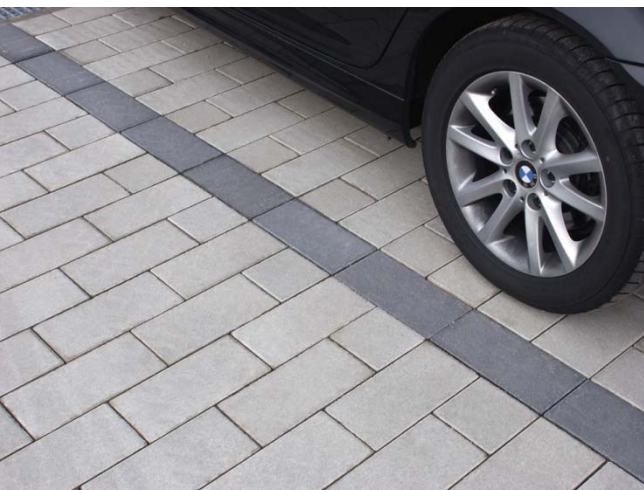
Foto inferior: Detall paviment
