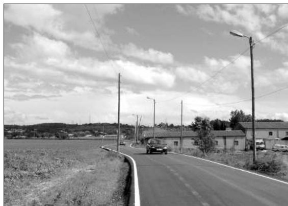
Una imatge de l'asfaltat i l'enllumenat del camí de Can Toni
