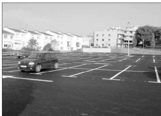
El nou aparcament de la zona esportiva municipal de Corró d'Avall té capacitat per a 130 vehicles
