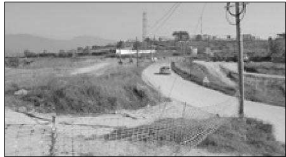
El camí de Can Carreró quedarà tallat per les obres de la Ronda Nord
