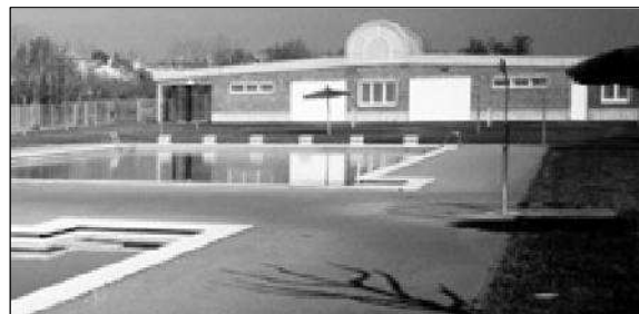
A l'edifici dels vestidors de les piscines d'estiu es construirà un bar amb terrassa
