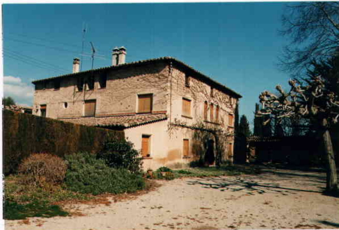
Vista general de la façana principal de l'habitatge. (Març, 1999)
