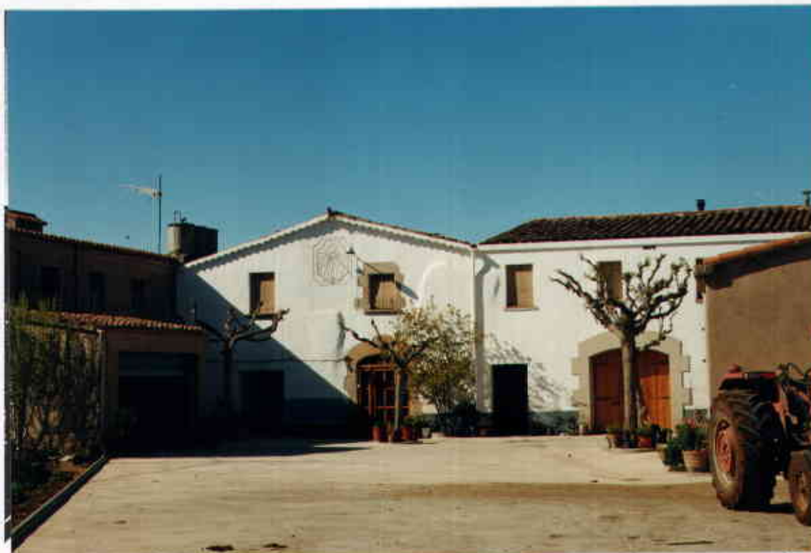
Vista general de la façana sud, des del pati d'accés a la masia. (Abril, 1999)
