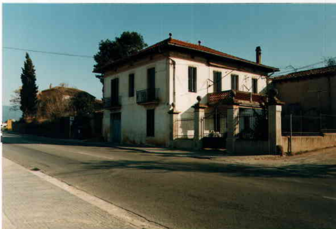
Vista general de l'habitatge, donat front a la carretera de Ribes. (Març,1999)
