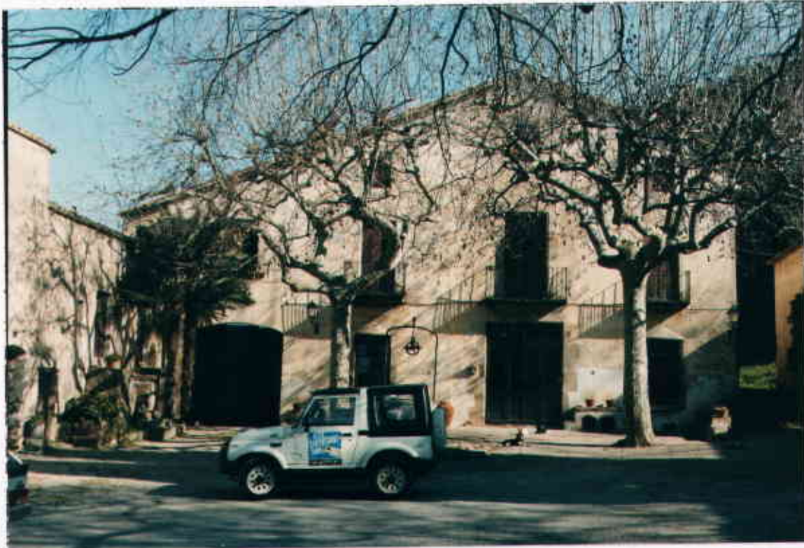
Vista frontal de la façana sud de la masia. (Març, 1999)
