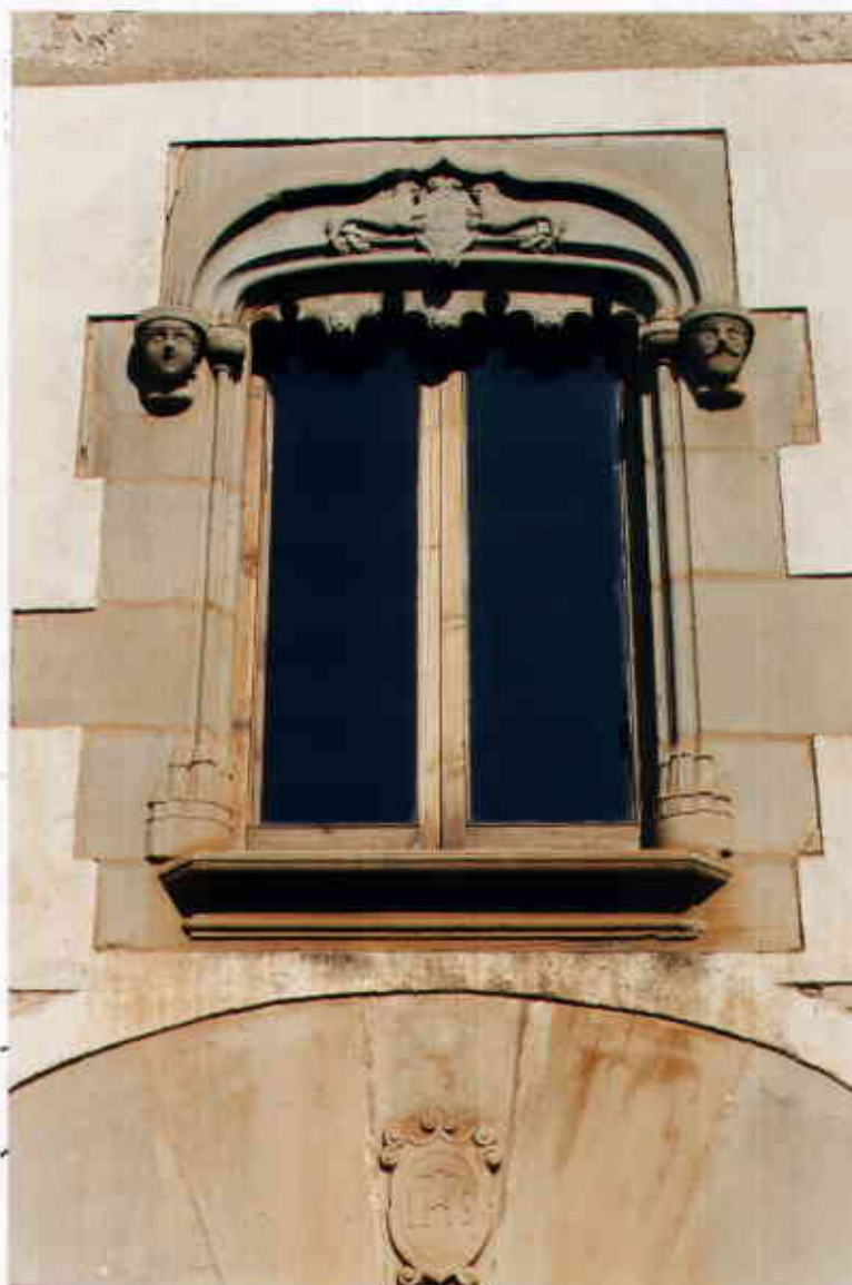
Detall de la finestra de la façana principal del pati. (Març, 1999)
