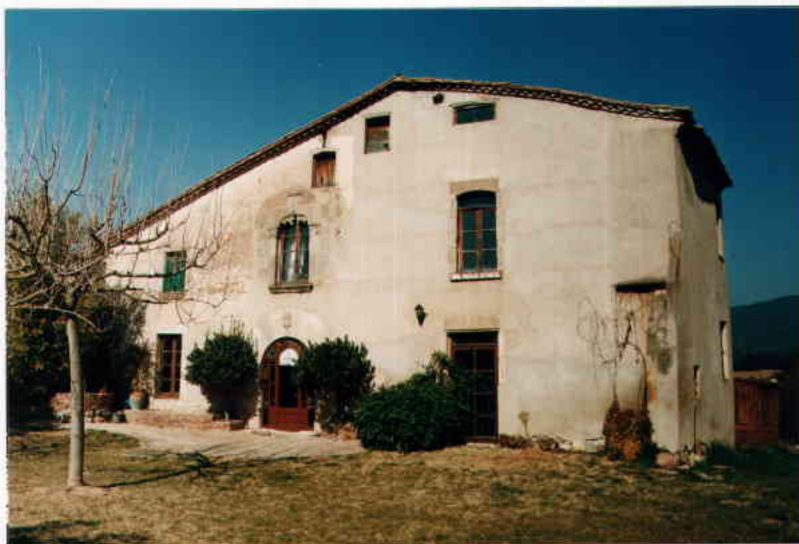
Vista general de la masia, façana sud. (Març, 1999)
