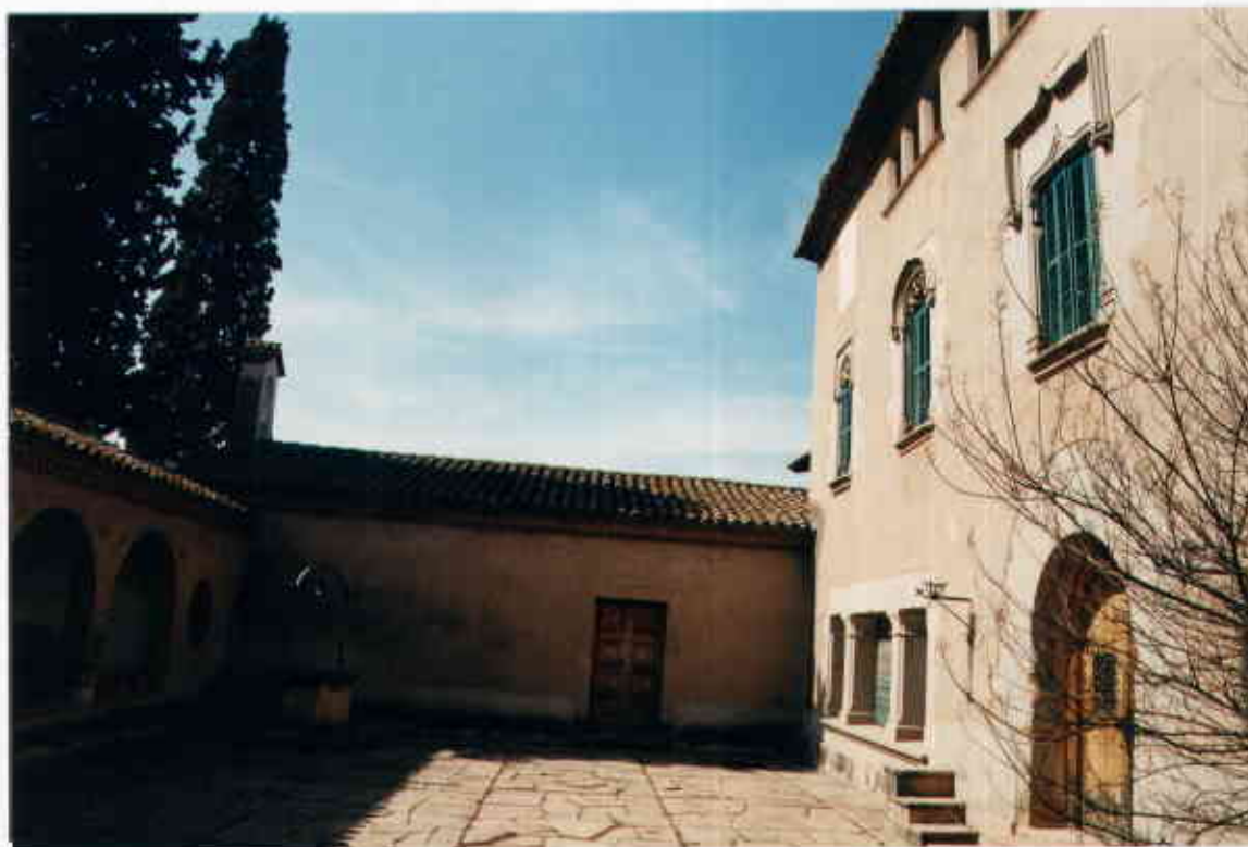
Vista parcial de la façana sud de l'habitatge principal i l'accés a la capella. (Març, 1999)
