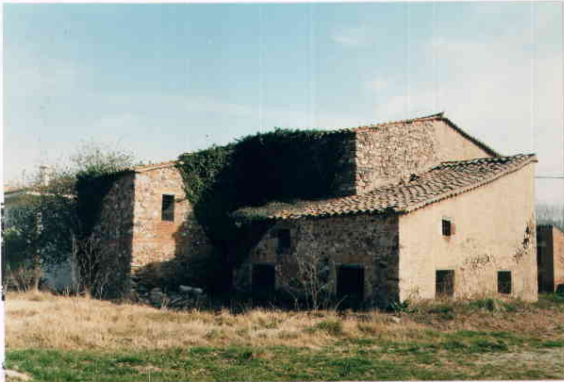
Vista general de l'habitatge. (Abril, 1999)
