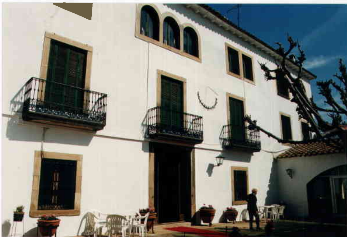
Vista parcial de la façana principal de l'habitatge. (Març, 1999)
