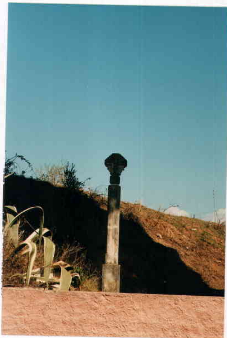
Vista general de la Creu de Terme. (Abril, 1999)
