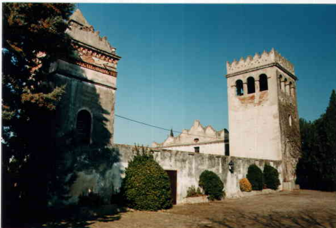
Vista general de la façana est (lateral) de la masia, paral·lela a la via ferroviària. (Març, 1999)
