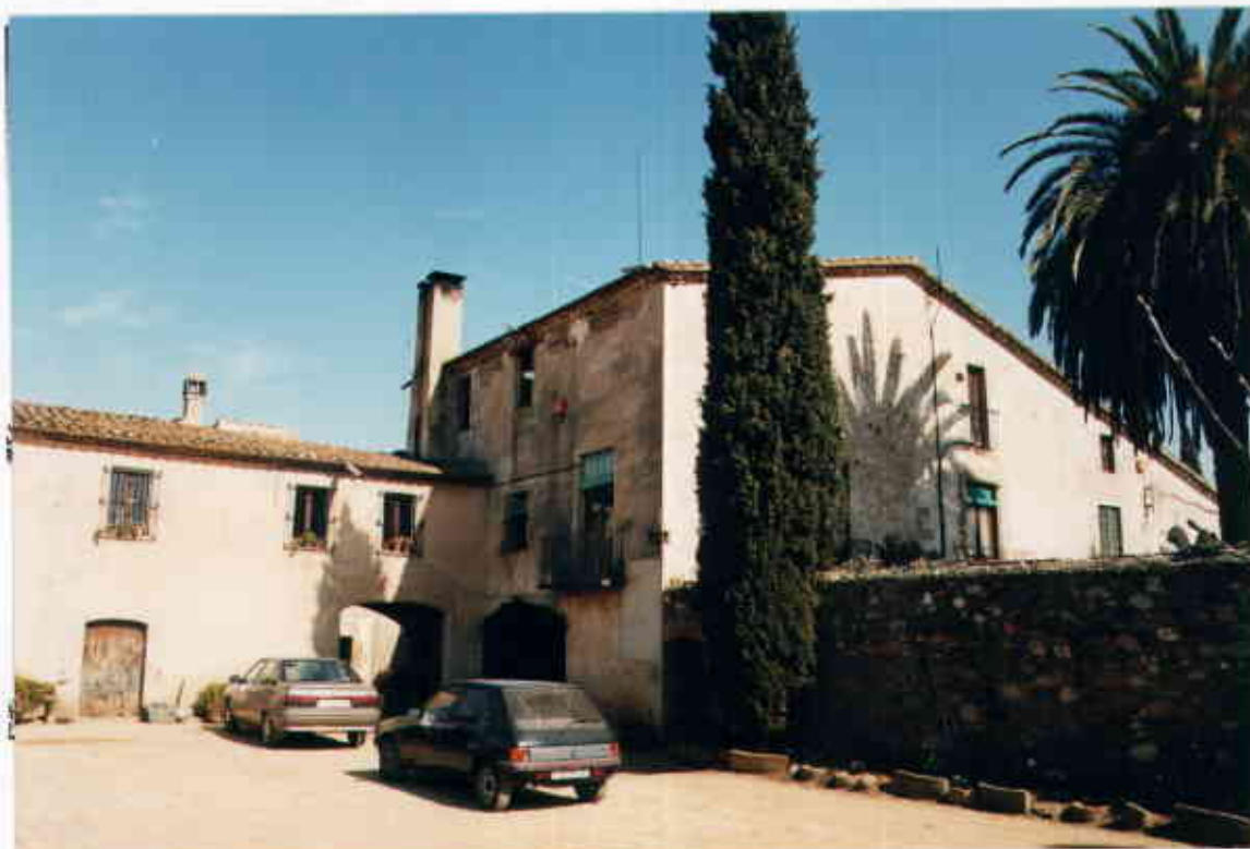
Vista general de la façana sud, d'accés l'habitatge. (Març, 1999)
