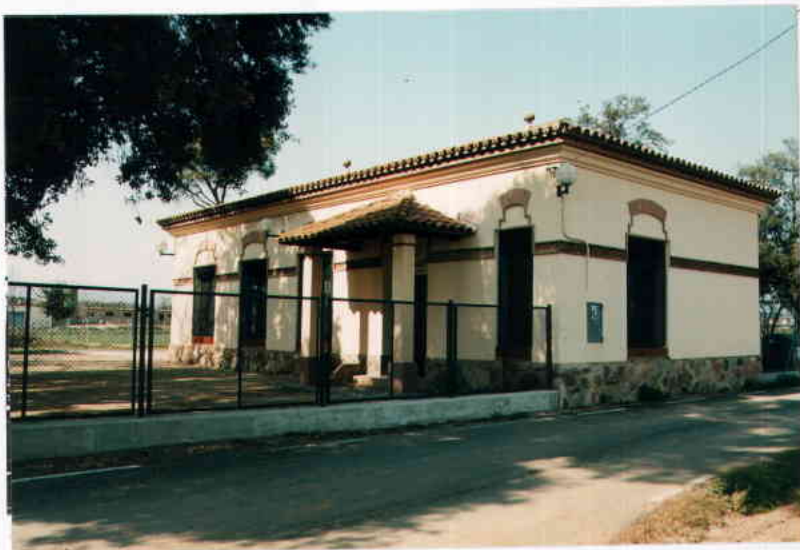
Vista general de l'edifici. (Març, 1999)
