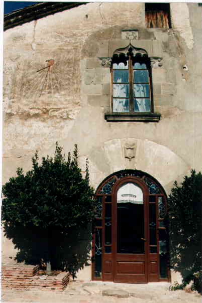
Detall de la porta i finestra de la façana principal. (Març, 1999)
