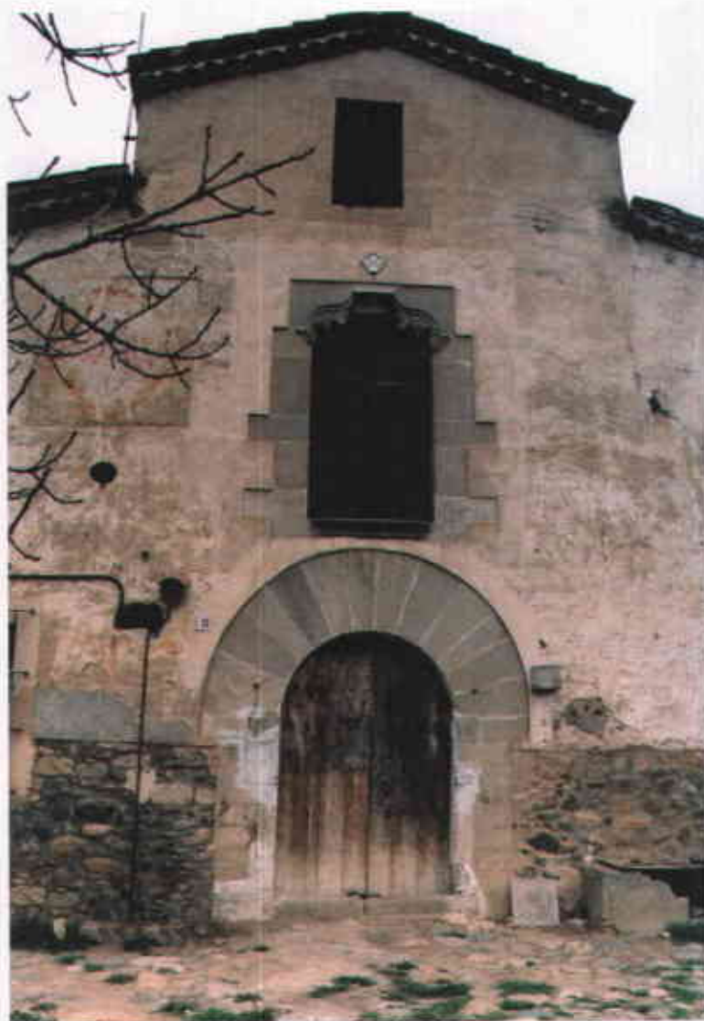
Detall de la porta i finestra de la façana principal. (Març, 1999)
