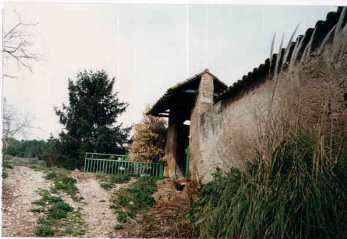
Vista del portal d'accés a la masia. ( Març, 1999)
