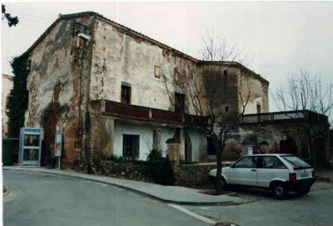
Vista general de l'edifici. (Març, 1999)
