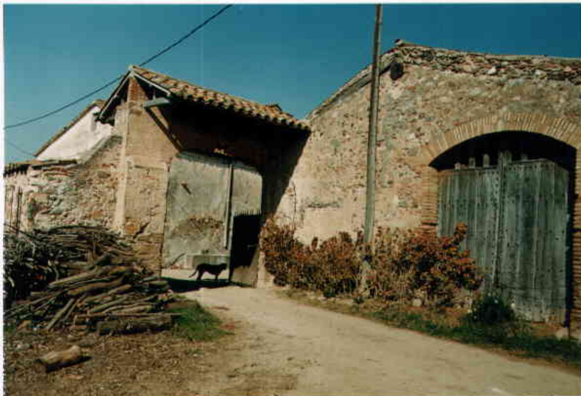
Vista del portal d'accés a la masia. (Març, 1999)
