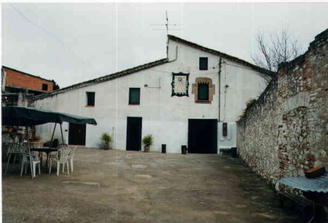
Vista general de la façana sud de la masia. (Març, 1999)
