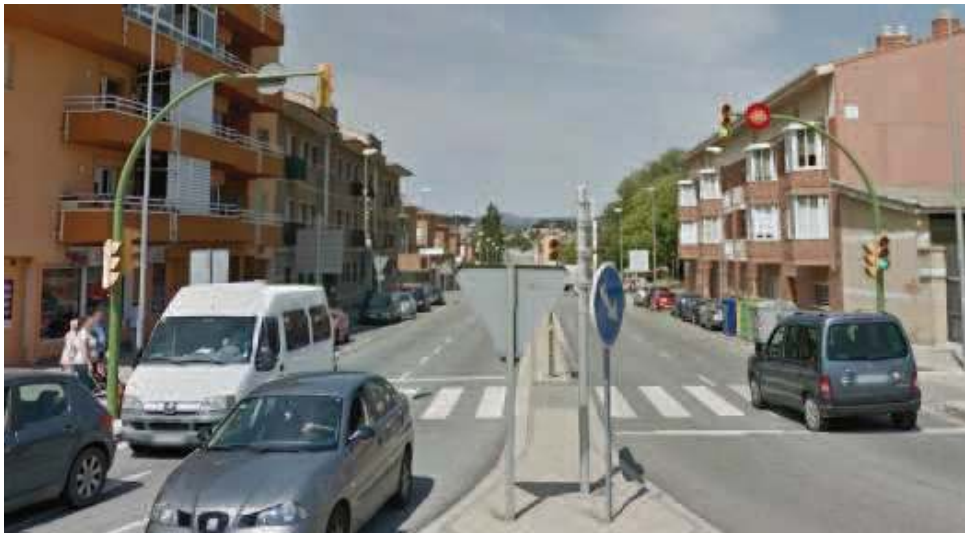
Figura 3: components semafòrics instal·lats després de la modificació. Font: google maps.
