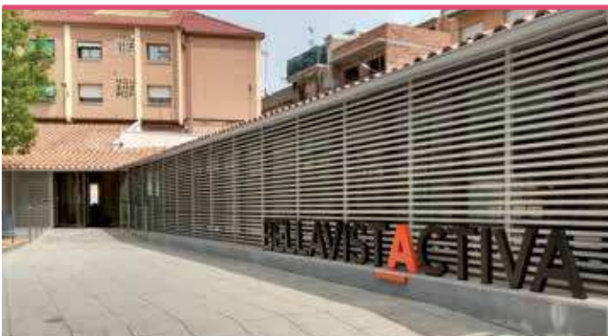
Bellavista Activa (SAC, oficina del Pla de Barris y oficinas de Polítiques Socials) se ha construido en la antigua guardería Massagran
