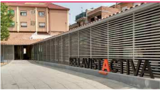
Bellavista Activa (SAC, oficina del Pla de Barris i oficines de Polítiques Socials) s'ha construït a l'antiga escola bressol municipal Massagran
