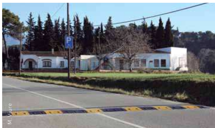
Els ressals tenen 80 cm de profunditat i una altura màxima de 4 cm
