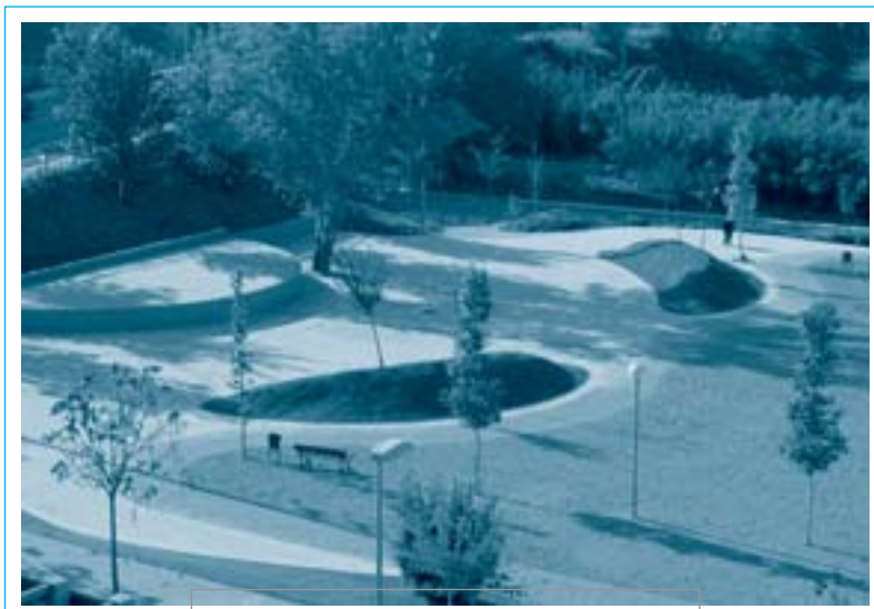
L'actuació s'ha realitzat a la part sud del parc
