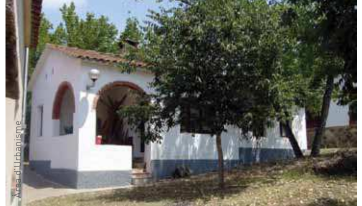
L'ampliació projectada es farà a la part sud de l'edifici
